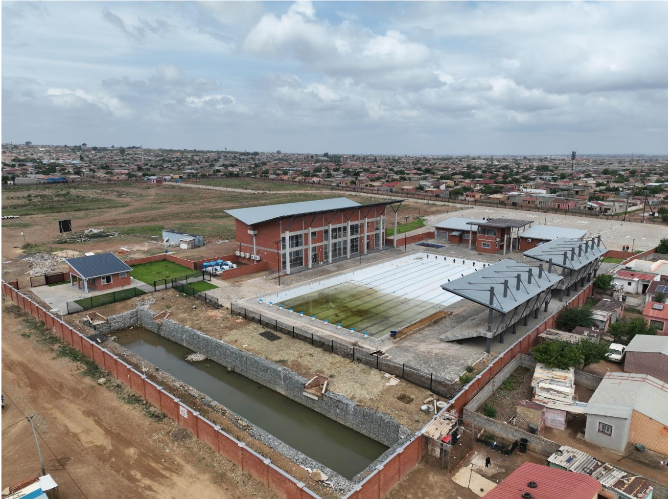
Drieziek Multi-Purpose Centre, Off the Golden Highway (R553) (26°28'9.05"S 27°50'7.79"E), Drieziek Ext 5
